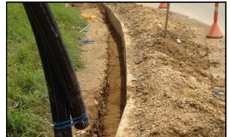
Instalación red de acueducto 4" PEAD - Multintegral.
