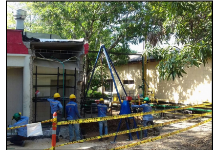
Pilotes Pre-excavados para Cafetería CABOT, DESCO.
